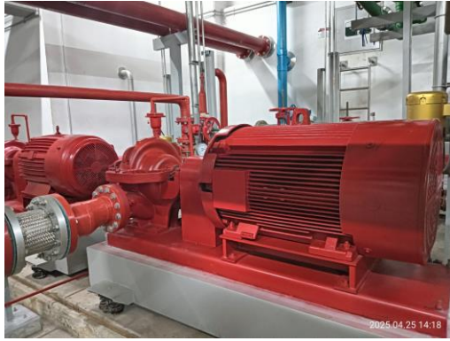
รูปที่ 3-48 เครื่องสูบน้ำดับเพลิง (Fire Pump)
