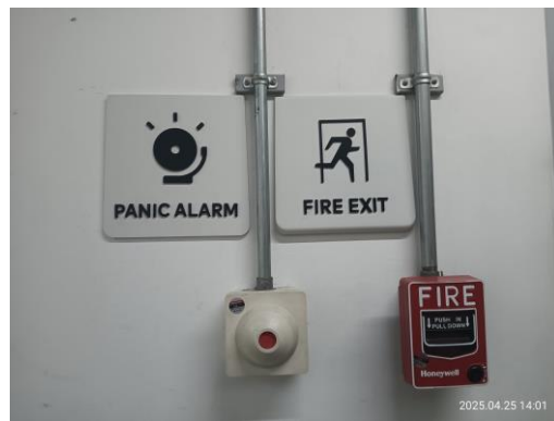
รูปที่ 3-57 เครื่องแจ้งเหตุโดยใช่มือดึง และกริ่งสัญญาณเตือนอัคคีภัย
