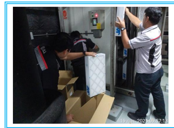
รูปที่ 3-41 การทำความสะอาดแผ่นกรองอากาศ
