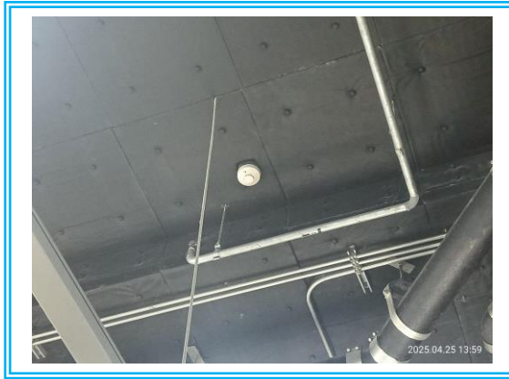
รูปที่ 3-37 เครื่องตรวจจับควัน (Smoke Detector) ภายในห้องหม้อแปลงไฟฟ้า
