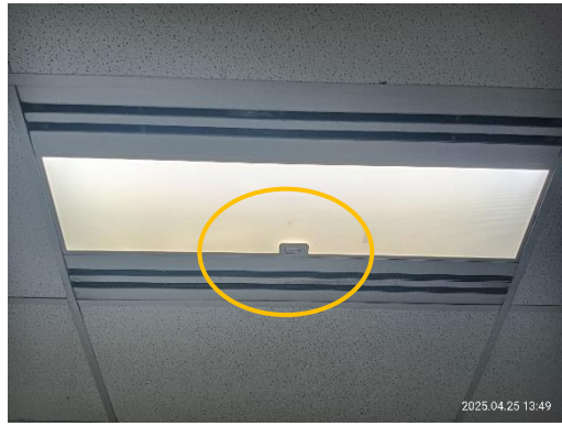
รูปที่ 3-44 อุปกรณ์ปรับระดับแสงสว่าง (Dimmer)
